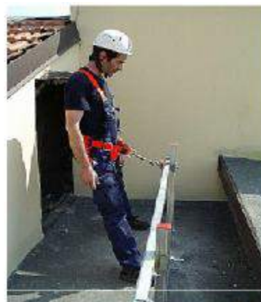
شکل ۴- محدودکننده با اتصال یک ریل مخصوص
