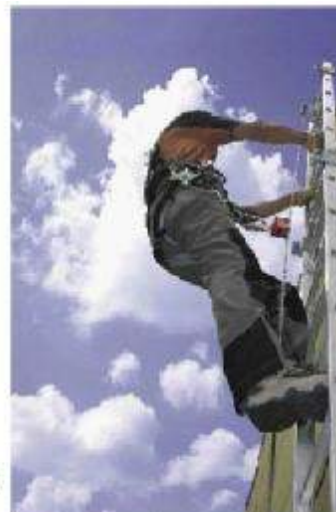
شکل ۷۷- صعود از نردبان با ابزار متوقف‌کننده
