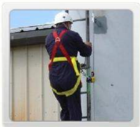
شکل ۷۶- صعود از نردبان با ابزار متوقف‌کننده
