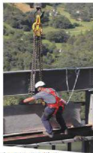
شکل ۷۵- استفاده از ابزار منوفک کننده در اجرای سازه فلزی
